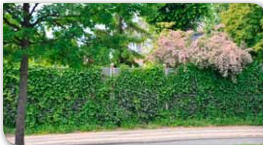
Pantalla acústica de acero galvanizado, lana de roca (como núcleo acústico) y una malla de polietileno verde
